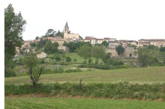
2 - Vue sur le flan Est depuis la RD 67 (direction Vénéès)
